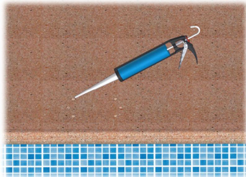
**Paso 4.** Insertar los 6 tacos de anclaje asegurándose que no hay obstáculos en los orificios. Si fuera necesario volver a aplicar el anclaje químico EPOXI en los laterales de los taladros para evitar que se creen vacíos de aire.
